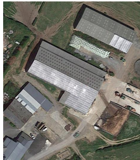
Figure 35 : Installation PV du SARL PHOTO IMAGE (Source : Géoportail)
