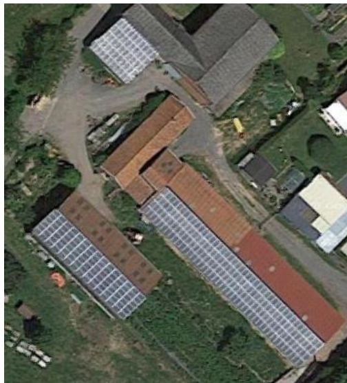
Figure 34 : Installation PV du SAS ELINSOL (Source : Géoportail)
