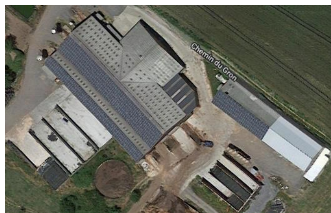
Figure 36 : Installation PV du GAEC de VILLIERS POL (Source : Géoportail)
