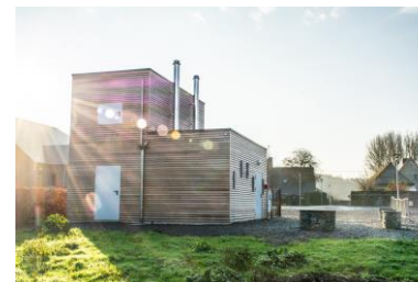
Source : Julie Godefroid – Chaufferie Bois-énergie Wallers-en-Fagne
