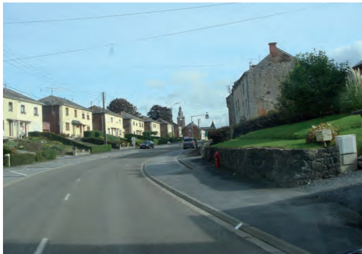
●● Habitat ouvrier à Trélon
