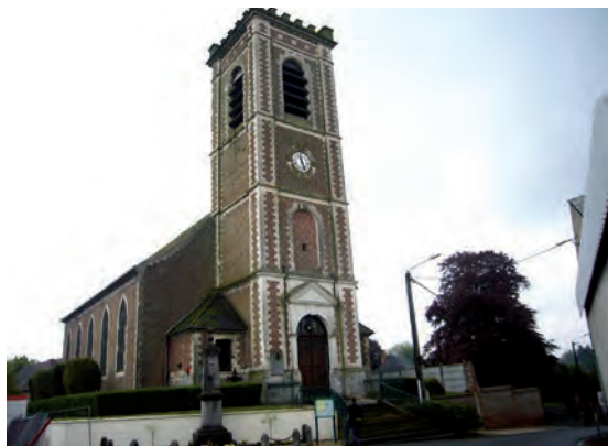
●● L'église de Jenlain, modifiée par l'architecte Fiévet
