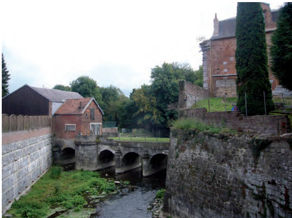
● ● Pont à Avesnes-sur-Helpe
