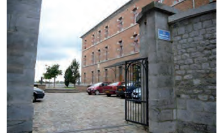
●● Casernes d'Avesnes, réhabilitées en logements
